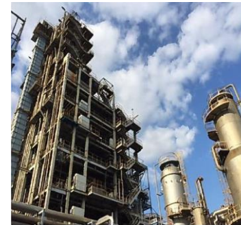
ケミカルリサイクル施設
