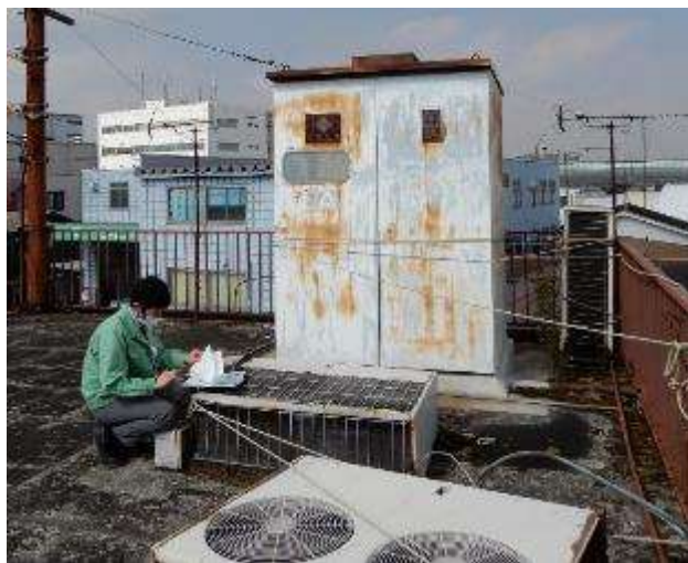
現地確認（掘り起こし調査）
