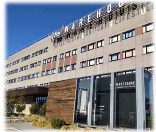
（活用事例） 燃料電池での発電に利用
