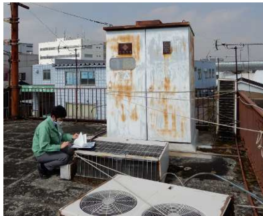
現地確認（掘り起こし調査）
