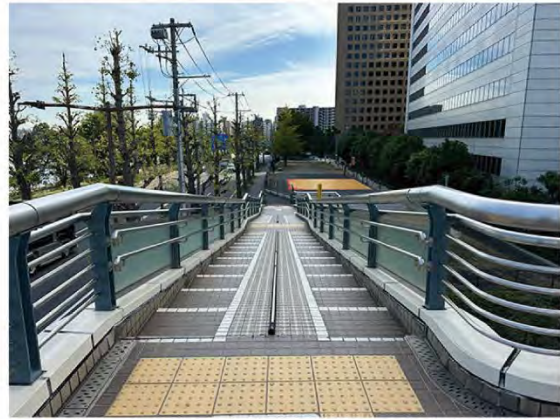
No. 12 : さいわい歩道橋の状況（南東を望む）
