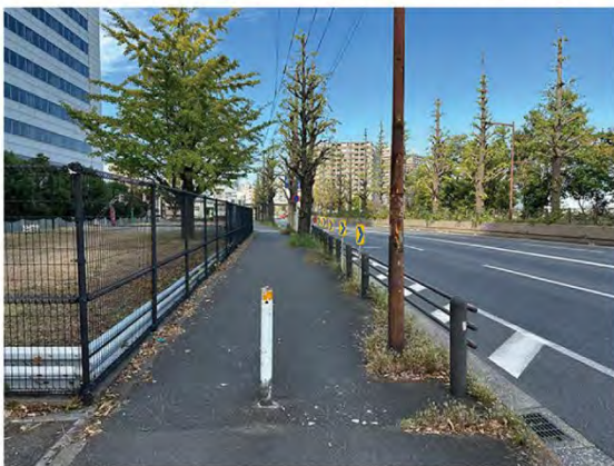
No. 15 : 国道 409 号歩道の状況（北西を望む）
