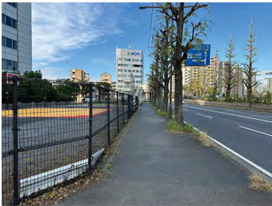
No. 13 : 国道 409 号歩道の状況（北西を望む）
