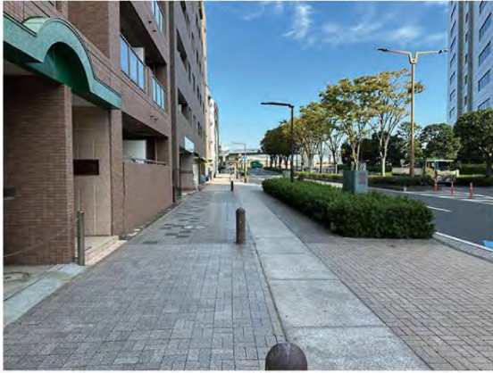
No. 9 : 川崎府中線歩道の状況（北を望む）
