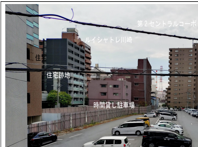
(計画地東側歩道橋(スロープ部)から西方向を望む) 撮影日: 令和8年5月8日
