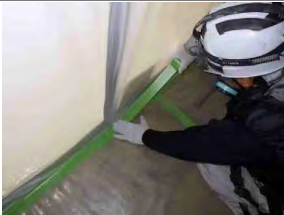
写真3.養生作業
