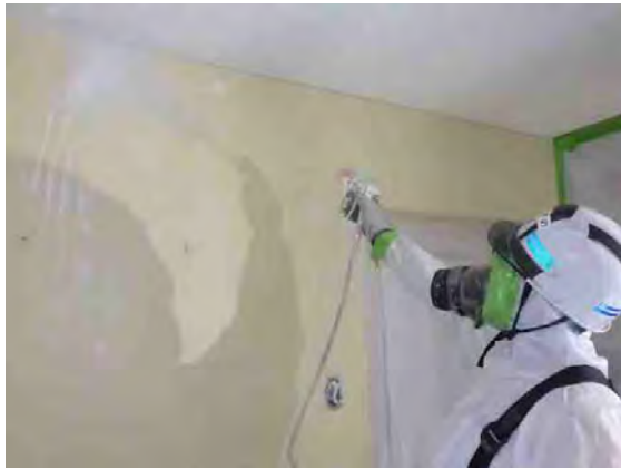
写真 9. 粉じん飛散抑制剤散布
