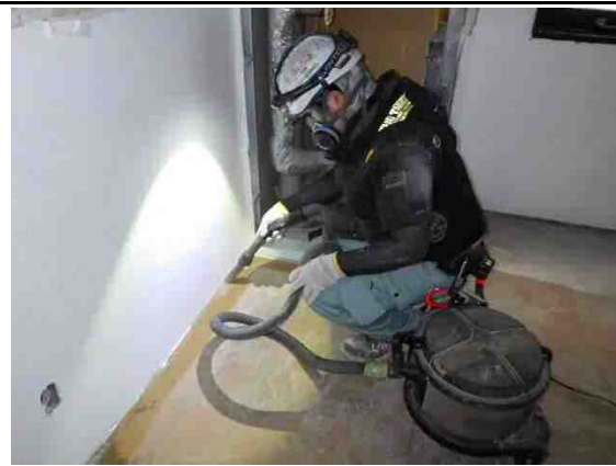
写真 18. 真空掃除機による清掃状況
