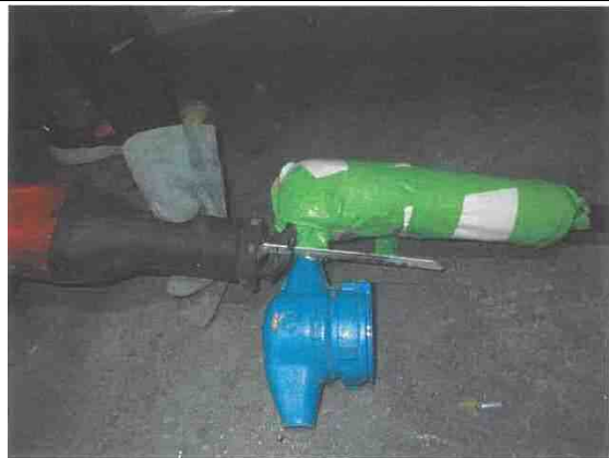
写真 13. 配管エルボ除去状況
