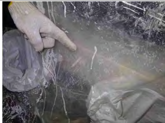
写真 14. グローブバック設置状況
