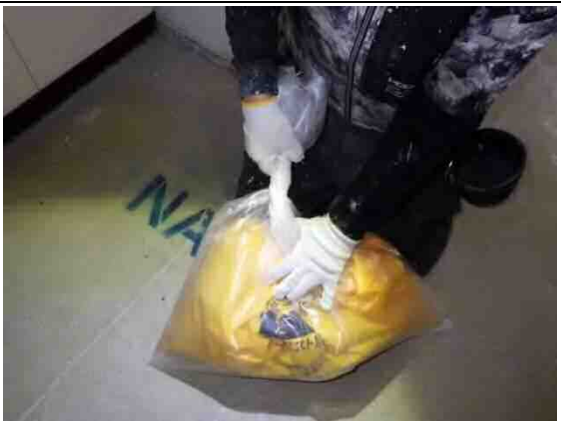
写真 16. 袋詰め(二重)状況
