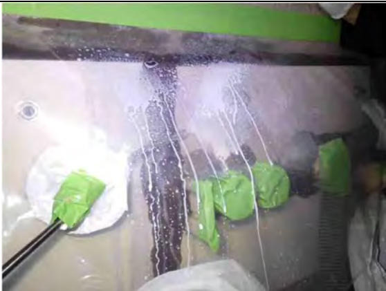
写真 15. グローブバック内作業状況
