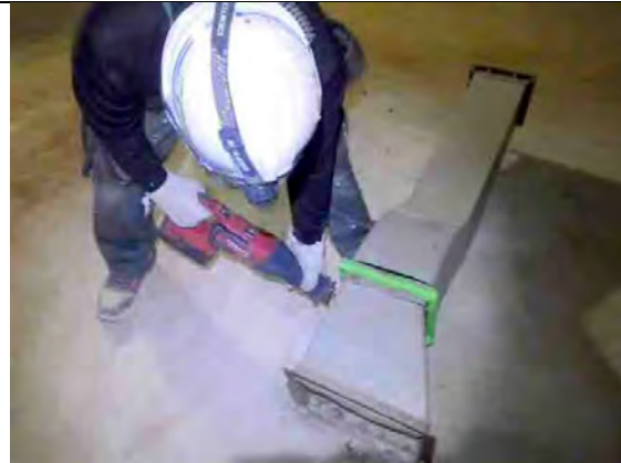
写真 12. フランジ除去状況
