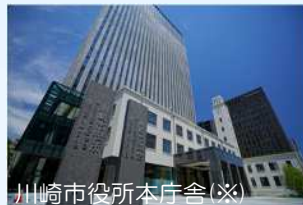
川崎市役所本庁舎(※)
