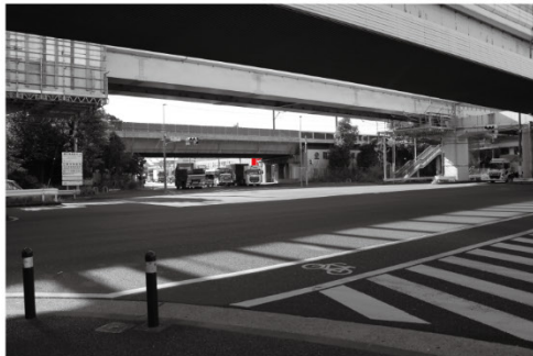
写真 4.7.1-5 代表的な眺望地点からの景観 (No.5 浜町交差点)
