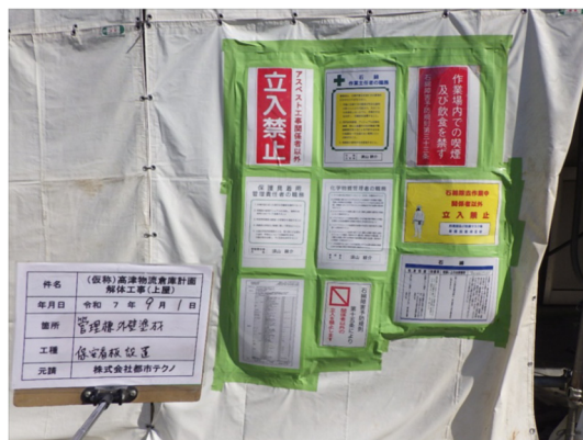
写真 3.1-2 保安看板の設置状況
