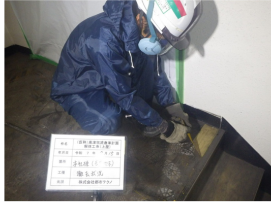
写真 3.1-10 手ばらしでの撤去
