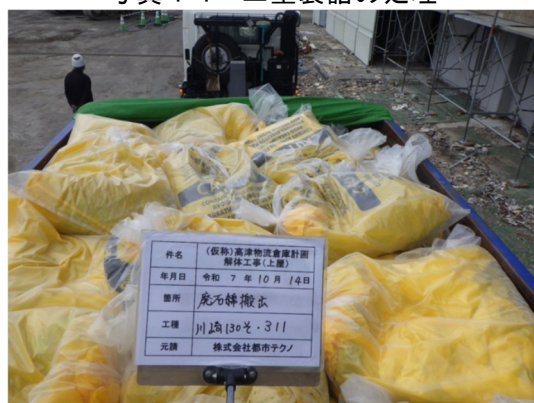
写真 1-3 廃石綿積込状況
