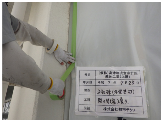
写真 3.1-6 開口部の養生作業
