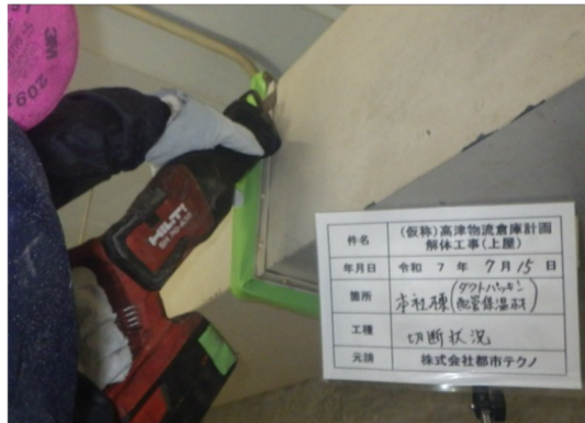
写真 3.1-12 設備パッキンの非石綿部での切断
