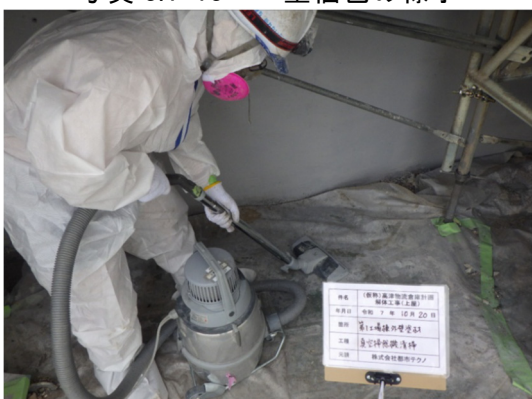
写真 3.1-15 真空掃除機による清掃
