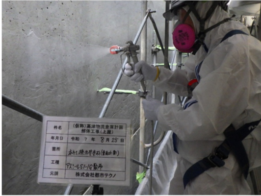
写真 3.1-17 飛散防止表面固着剤の散布
