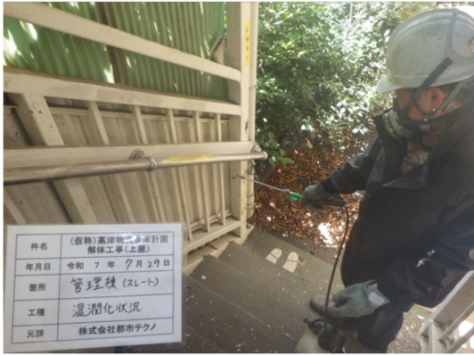
写真 3.1-9 散水等の湿潤措置
