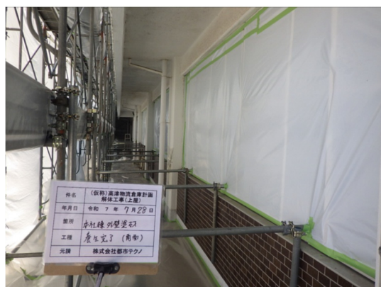
写真 3.1-7 隔離養生の状況
