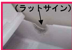
（ラットサイン） 食品を入れた引出（プラスチック）をかじり侵入
