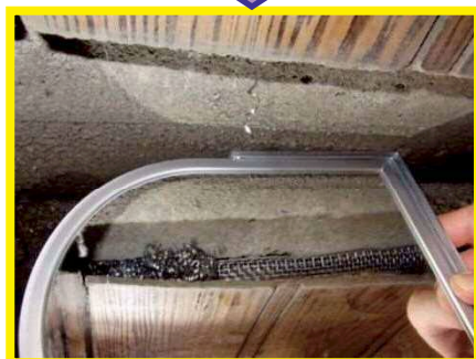
基礎と外壁のすき間に 金網を詰める
