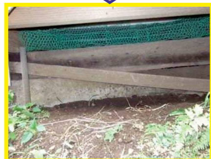
床下の基礎のすき間に 金網を詰める
