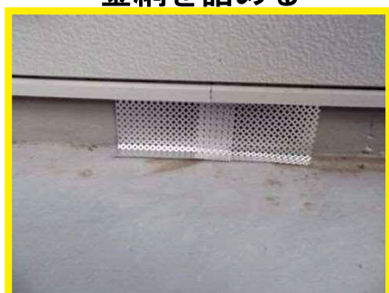
基礎部の床下換気口に 穴あき金属板設置
