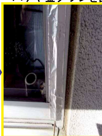
アルミテープによる すき間補修
