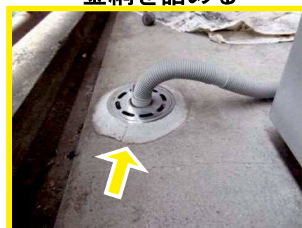
洗濯機の排水口周囲に パテや金タワシを詰める
