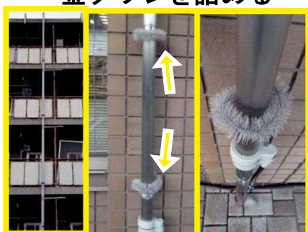
屋外配管に 防そブラシを巻きつける
