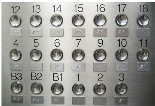
エレベーターの階数を点字で示しています。
