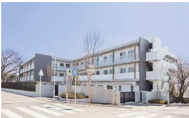
障害者支援施設 桜の風 (中原区)
