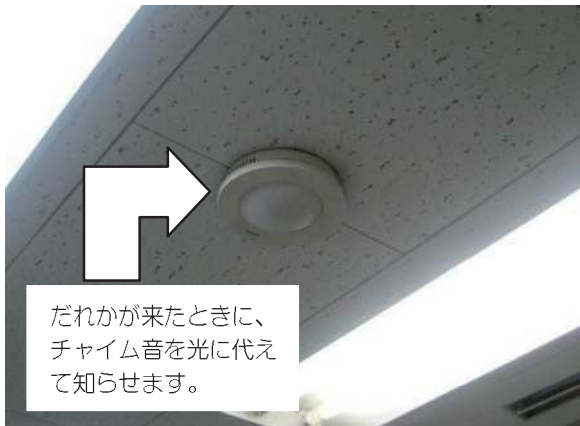
チャイム音を光の情報に変える機器
