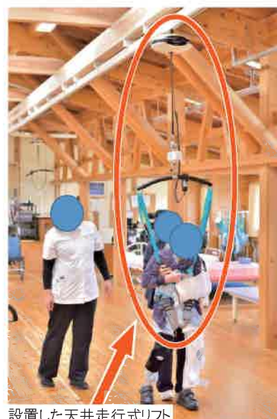
設置した天井走行式リフト
