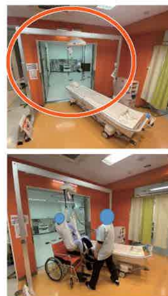
MRI検査室専用のリフトを導入
