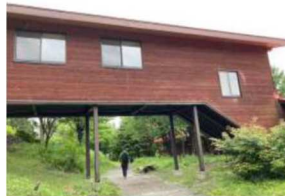
鳥の棟渡り廊下
