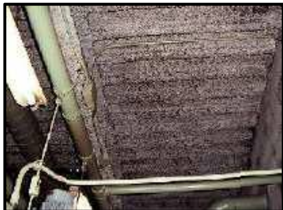
吹付け材※ 3 の例（床・天井）
