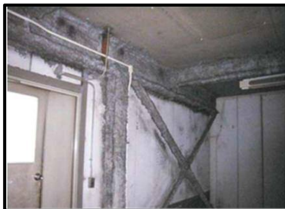
吹付け材※ 3 の例（梁・柱）
