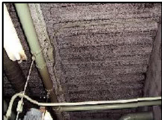
吹付け材※ 3 の例（床・天井）
