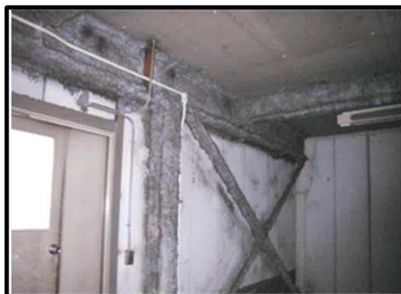
吹付け材※ 3 の例（梁・柱）
