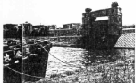
川崎河港水門
