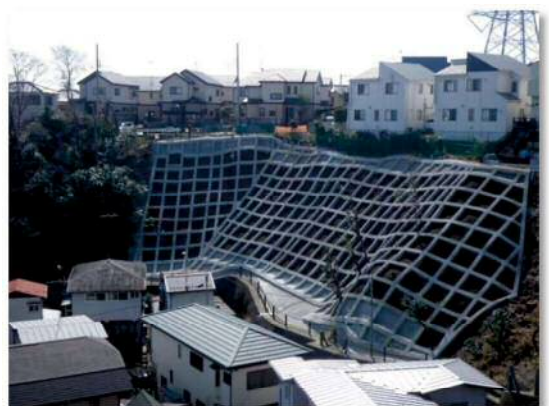
急傾斜地崩壊対策工事の事例
