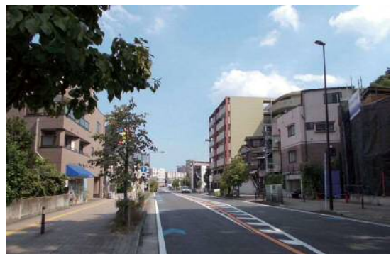
無電柱化された道路
