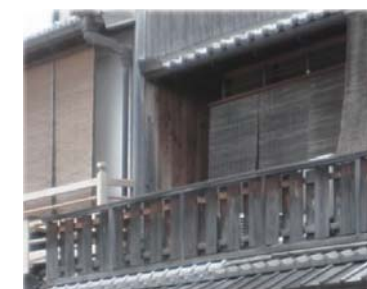
和風の手摺の設置
