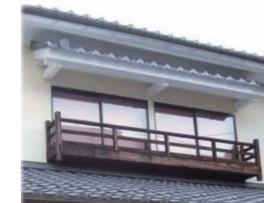
和風の手摺の設置
