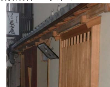
和風庇・窓格子の設置
