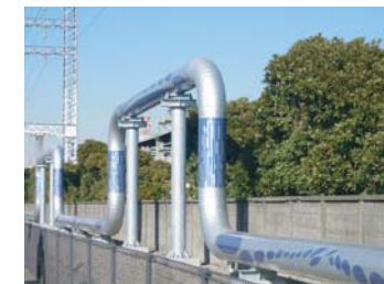
コンペによる配管デザイン
