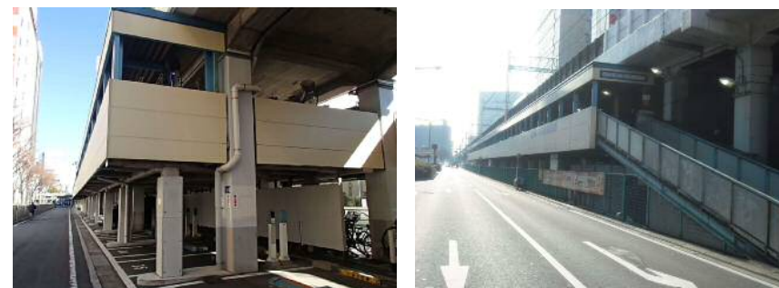
※ 川崎駅東口の既存高架下駐輪場
