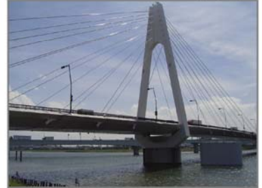
大師橋は、川崎の玄関口にふさわしく、美しく洗練されたデザインになっています。
