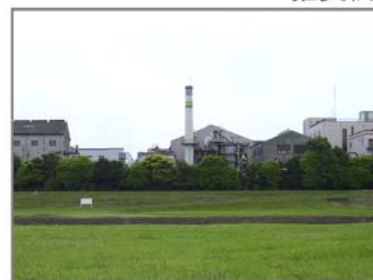
工場のコンクリート塀の外周は植栽帯で緑化されています。
