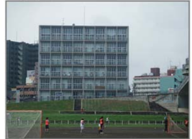
水辺空間を意識した建築物のファサード。
