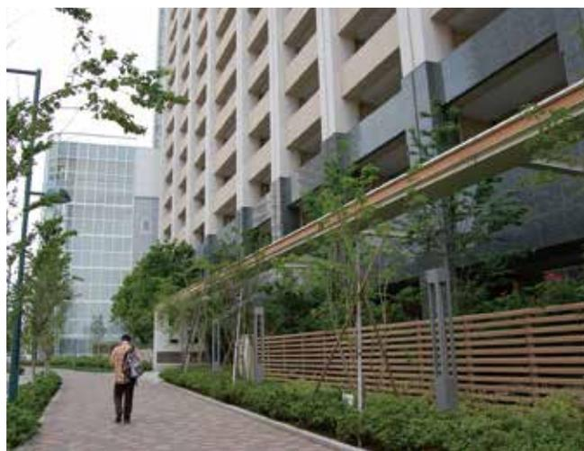
低層部の外壁の色彩を変えることで、中間部との分節化を図るとともに、ルーバーフェンスにより道路から居室までの距離を適正にコントロールしています。
