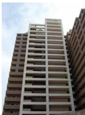
外階段の立面を大胆なアウトフレームにより、廊下としての機能が表出する外観の印象を軽減しています。
