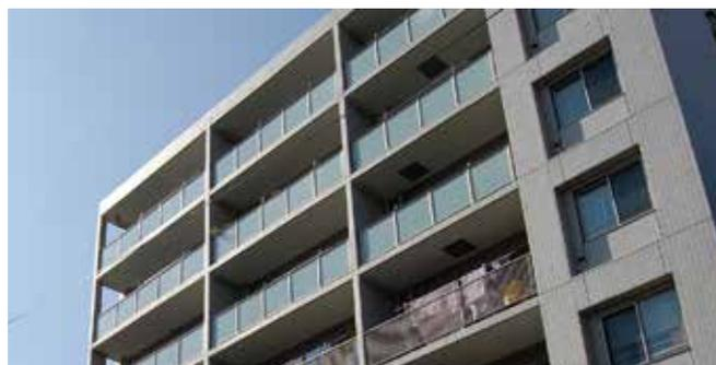
バルコニーに垂直方向のマリオンを設けて垂直方向の分節化を行ない、水平方向部材と見付寸法をそろえることで、外観を整えています。
