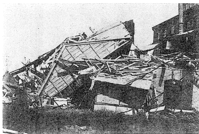
写真122 震災で倒壊した浅野セメントの工場 『関東大地震 震害調査報告』 3
