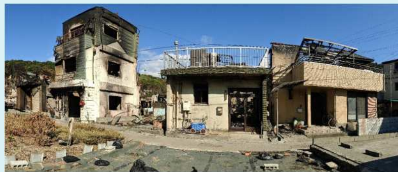
写真2 焼け止まりの空地や建物
