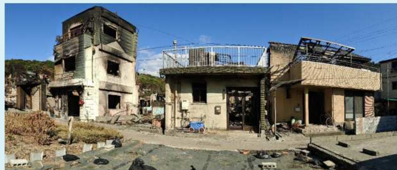
写真2 焼け止まりの空地や建物
