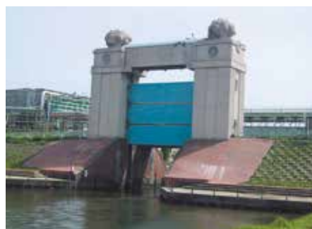
川崎河港水門
