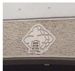
建築物躯体に彫り 込んだ例
