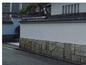
瓦を取り入れた塀
