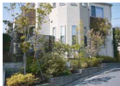
道路沿いにフェンスや植栽を施し、圧迫感の軽減と緑豊かな街なみを形成している
