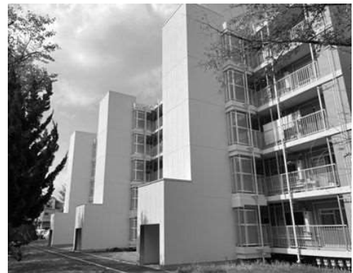
エレベータ設置事例
