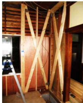
《木造住宅の耐震改修工事の様子》
