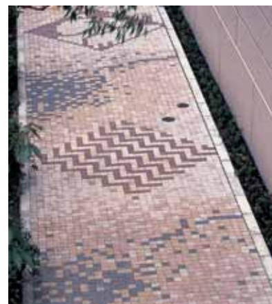
完成した「季節の抜け道」
