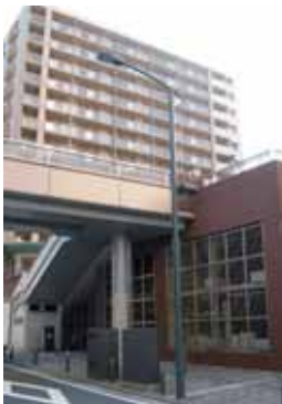
地区の景観コンセプトに基づいた照明(幸区)
