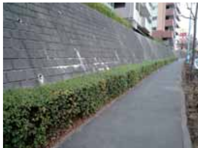
植栽配置と表面仕上げを工夫した擁壁 （横浜市）
