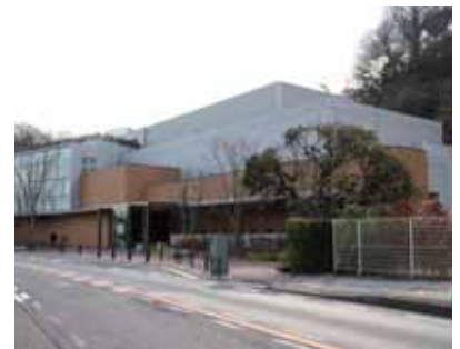
斜面緑地を背景として活かした「藤子・F・不二雄ミュージアム」(多摩区)
