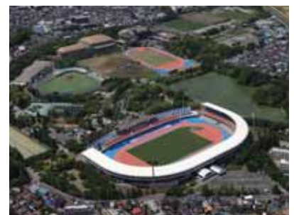
スポーツ、文化の発信地として様々な施設が立地する等々力緑地(中原区)
