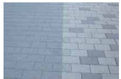
切り込みとインターロッキングの色の違いで境界を明示(幸区)
