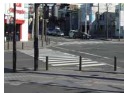
必要最小限の道路付属物を配備した交差点 （麻生区）
