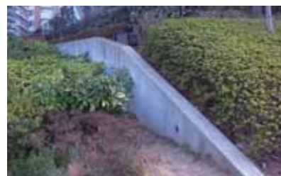
擁壁前面への緑化(幸区)
