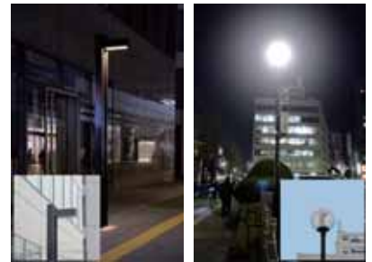
光害に配慮した街灯（左） 光害に配慮していない街灯（右）
