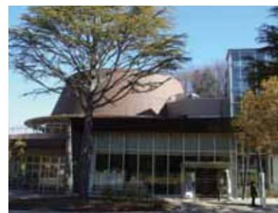
生田緑地内の緑と調和を図るため、色彩・形態等に配慮した施設(多摩区)
