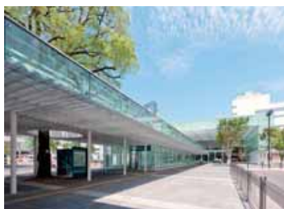
柵、舗装、植栽等が調和し、空間全体が「図」として機能している川崎駅東口駅前広場(川崎区)
