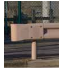
塗装面が比較的大きい車両用防護柵（グレーベージュ）（川崎区）
