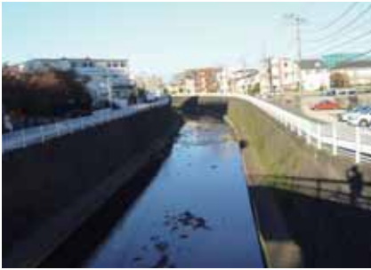
治水を目的としたコンクリート護岸となっている平瀬川(高津区)
