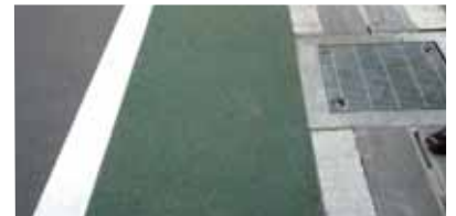
明度を抑えたカラー舗装(麻生区)
