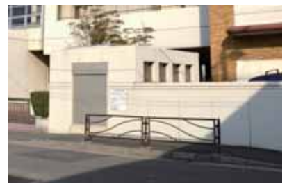
建築物本体の外観デザインにあわせた倉庫(東京都)
