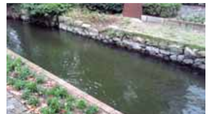
石材を使用した風合いのある護岸(岡山県)
