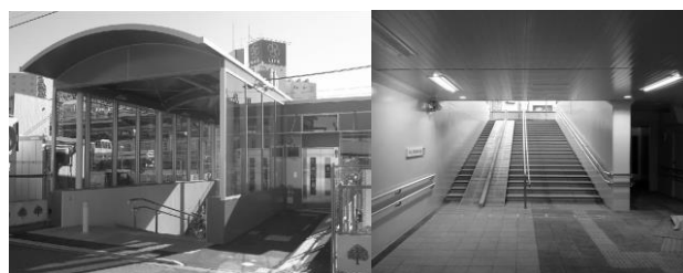
図 向ヶ丘遊園駅連絡通路
