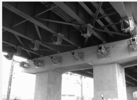
図 小倉跨線橋の落橋防止ケーブル
