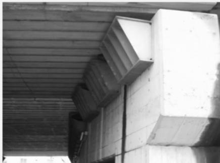
図 塩浜陸橋の縁端拡幅
