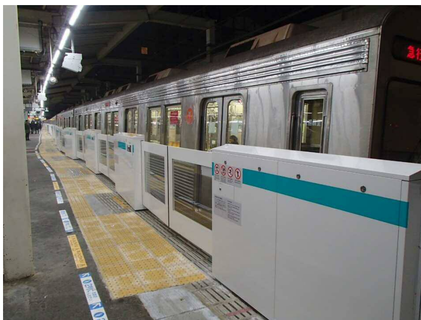
図 東急田園都市線溝の口駅ホームドア
