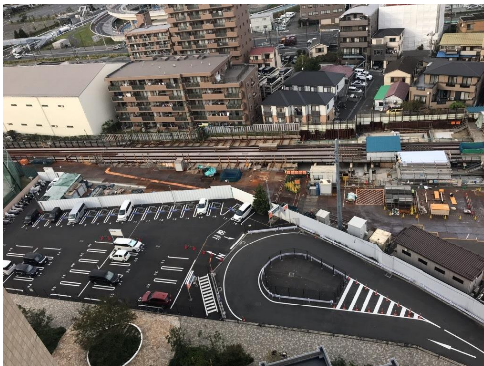
駅前交通広場の建設予定地（現況）
