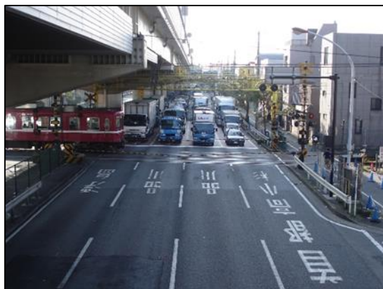
産業道路第一踏切(除却前)
