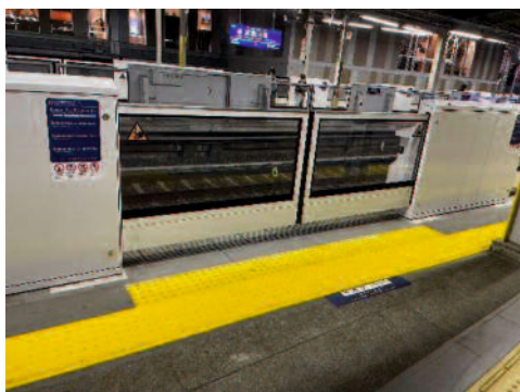
京急本線京急川崎駅上り線ホームドア
