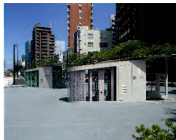
小川町地区の地下機械式駐輪場（入口）
