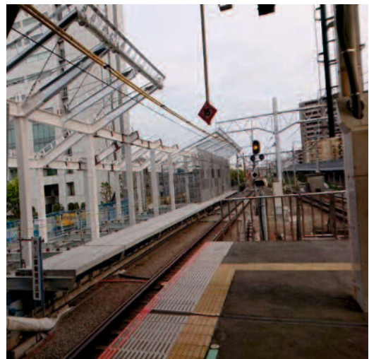
JR 横須賀線下りホーム新設工事の現状（令和3年4月）
