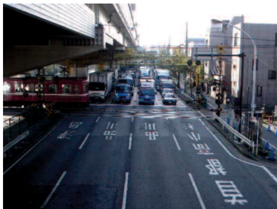
産業道路第1踏切(除却前)
