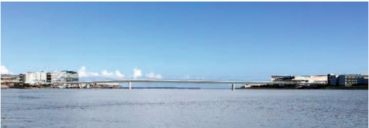
羽田連絡道路 完成イメージ図 (令和 3 年 7 月に名称が「多摩川スカイブリッジ」に決定しました)
