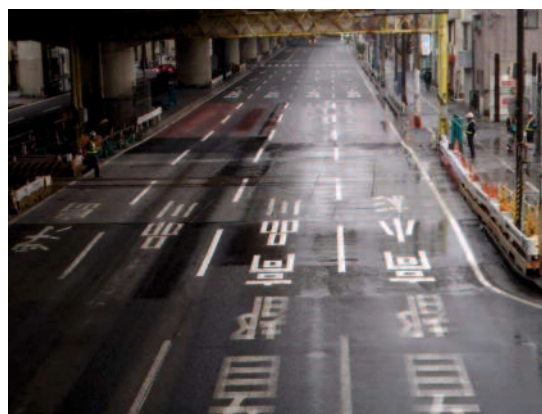
産業道路第1踏切(除却後)
