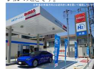
川崎高津水素ステーション
