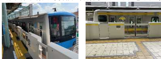
左: 小田急小田原線登戸駅上り線ホームドア、右: JR南武線武蔵小杉駅ホームドア
