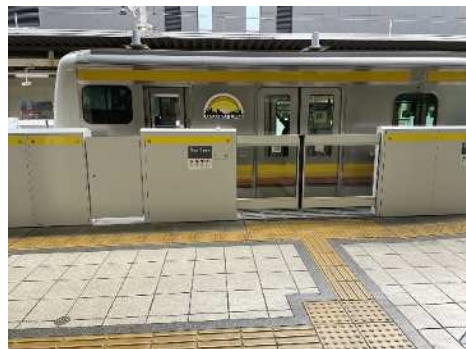
JR 南武線武蔵小杉駅ホームドア
