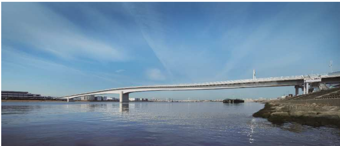
多摩川スカイブリッジ 全景
