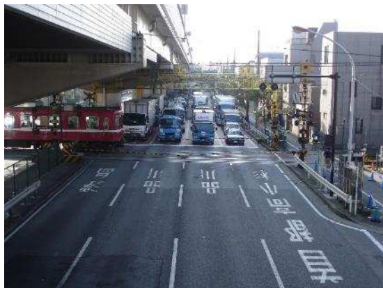
産業道路第1踏切(除却前)
