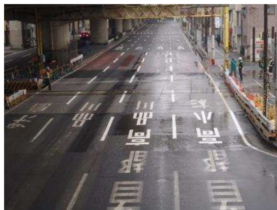
産業道路第1踏切(除却後)
