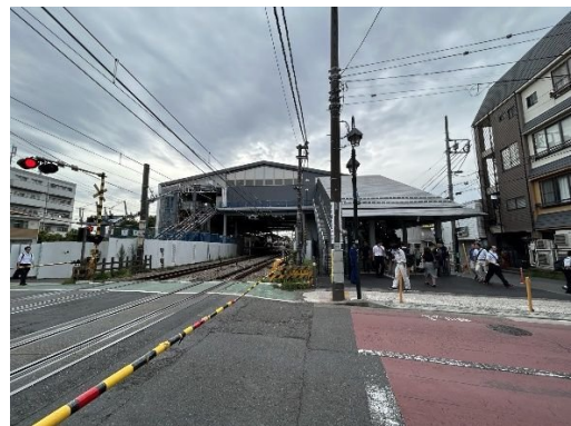
自由通路南側使用開始後の状況 （令和 5 年 8 月）
