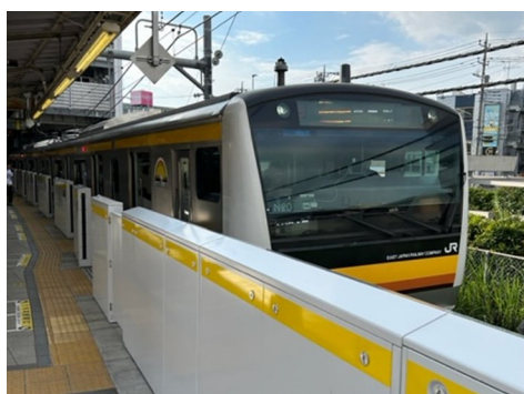
JR 南武線登戸駅（本線）ホームドア （令和5年度整備完了）
