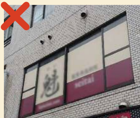
▲窓面の外側に直接貼り付けて掲出することは避ける
