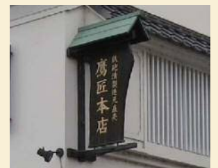
▲袖看板（建物の壁面から突出して設置するもの）を設置
