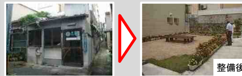
老朽建築物の除却 ⇒ 防災空地の創出
