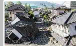
建物倒壊による道路閉塞
