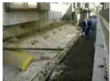
危険なブロック塀の倒壊例
