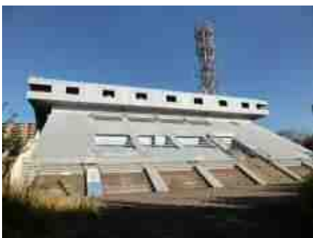
南部防災センターの様子
