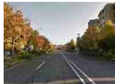
都市計画道路 富士見鶴見駅線 (渡田東町付近の様子)
