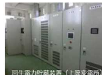
回生電力貯蔵装置（上原変電所）
