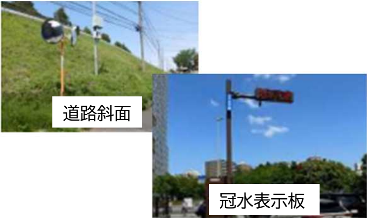
適切な維持修繕や維持管理(道路斜面・冠水表示板) (出典:川崎市道路維持修繕計画)
