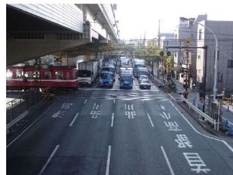
産業道路第1踏切(除却前)
