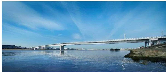
多摩川スカイブリッジ（羽田連絡道路）全景
