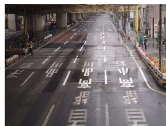
産業道路第1踏切(除却後)
