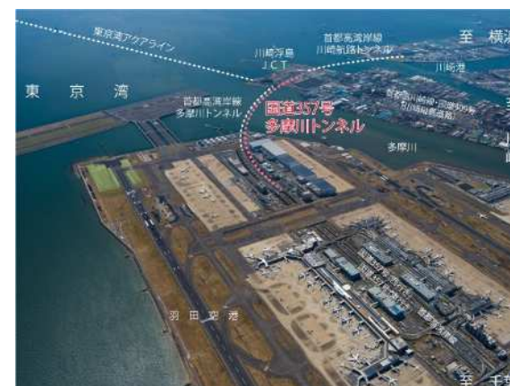
国道357号多摩川トンネル航空写真 (関東地方整備局 川崎国道事務所)
