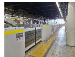
ホームドアの設置 (JR南武線武蔵小杉駅)
