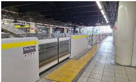
ホームドアの設置 (JR東日本南武線 武蔵小杉駅)
