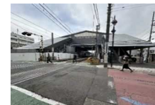
橋上駅舎化されたJR稻田堤駅
