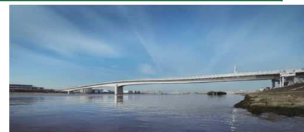
多摩川スカイブリッジ
