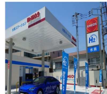
川崎高津水素ステーション
