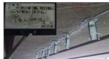
橋りょう桁下の予防保全的な修繕の例 (ひび割れに樹脂を注入)
